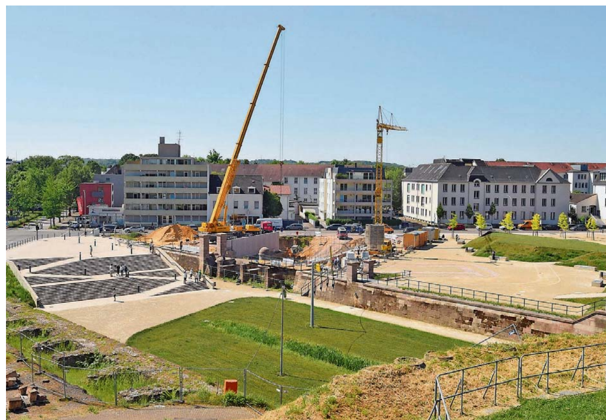
Die Brücke wird rechts und links von zwei rekonstruierten Pfeilerpaaren begrenzt.
