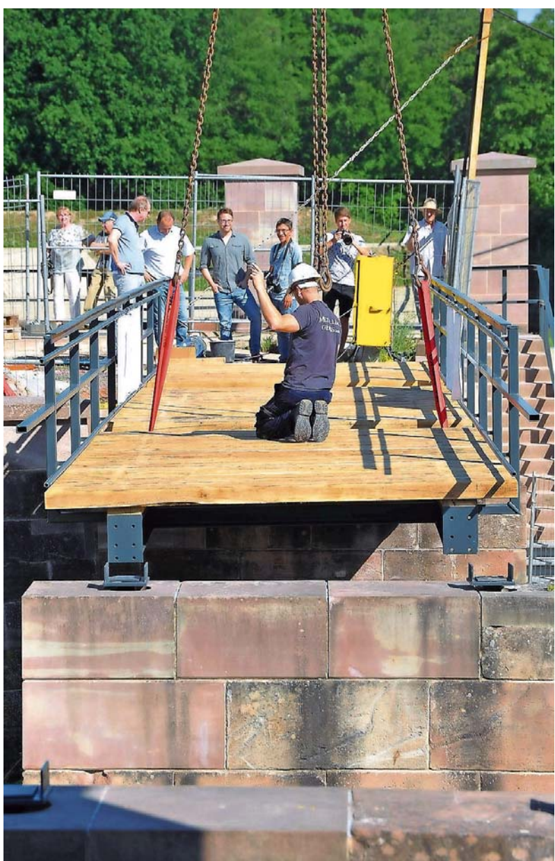
Das erste der beiden Teilstücke wird auf die originalen Sandsteinpfeiler aufgesetzt.
