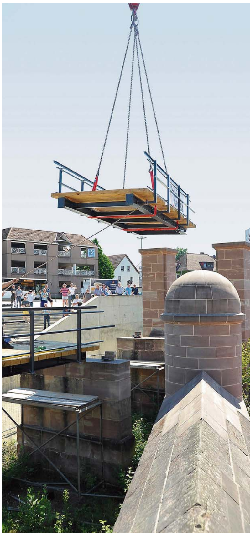
Das zweite Brückenteil schwebt ein.
